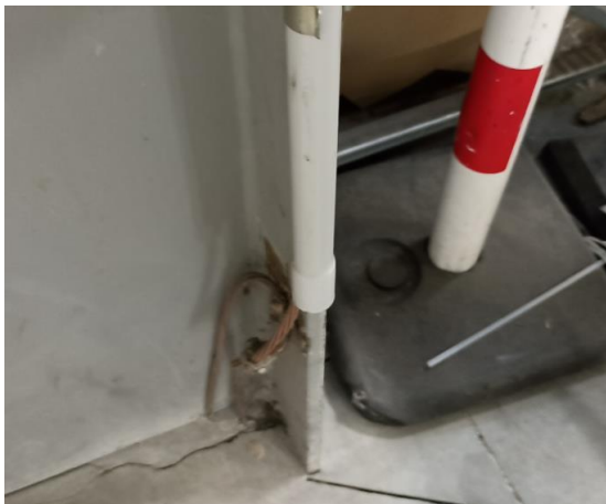
Figure 6 : Mise à la terre des structures métalliques du bâtiment
